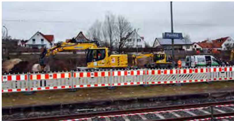
Bauarbeiten am Bahnhof Pleinfeld.
